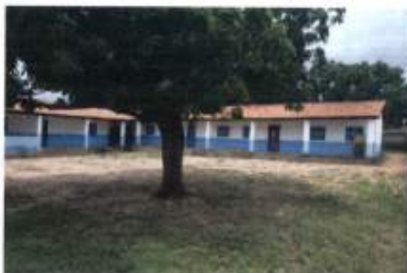
TERRENO PARA CONSTRUÇÃO DA QUADRA
