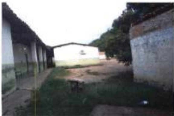
TERRENO PARA CONSTRUÇÃO DOS BANHEIROS
