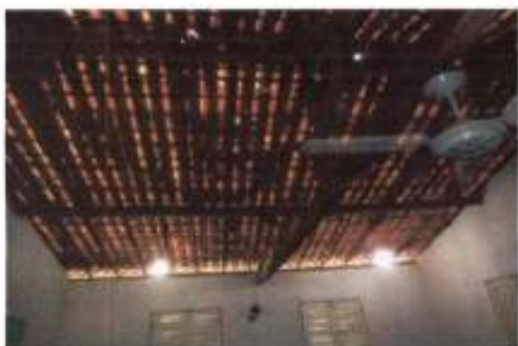
VISTA DO TELHADO
