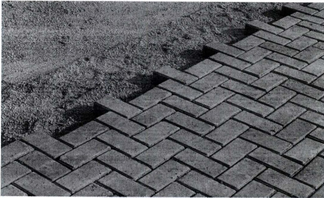
Figura 2 - Detalhe do piso intertravado
